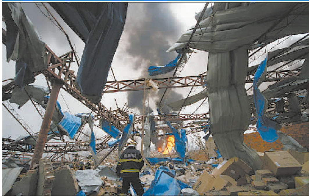
7月28日,消防人员在爆炸事故现场附近的建筑物内灭火。新华社发
